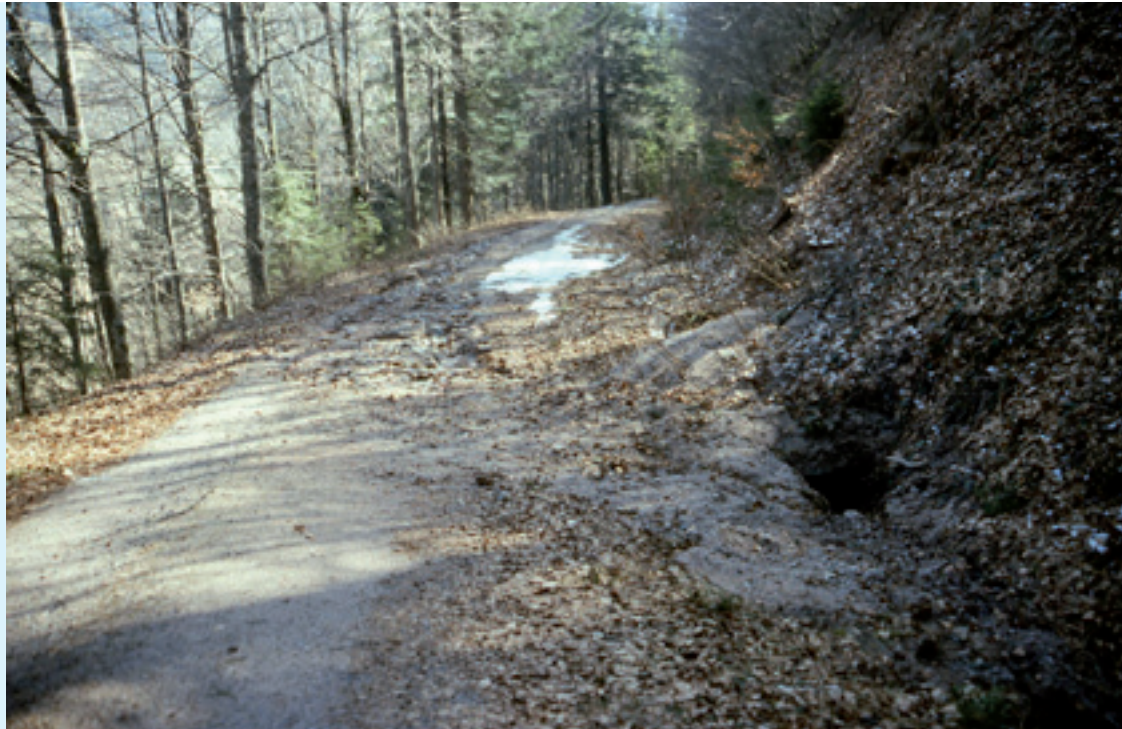
Abb. 30: Auffüllung der bergseitigen Böschung vor dem Doleneinlauf
