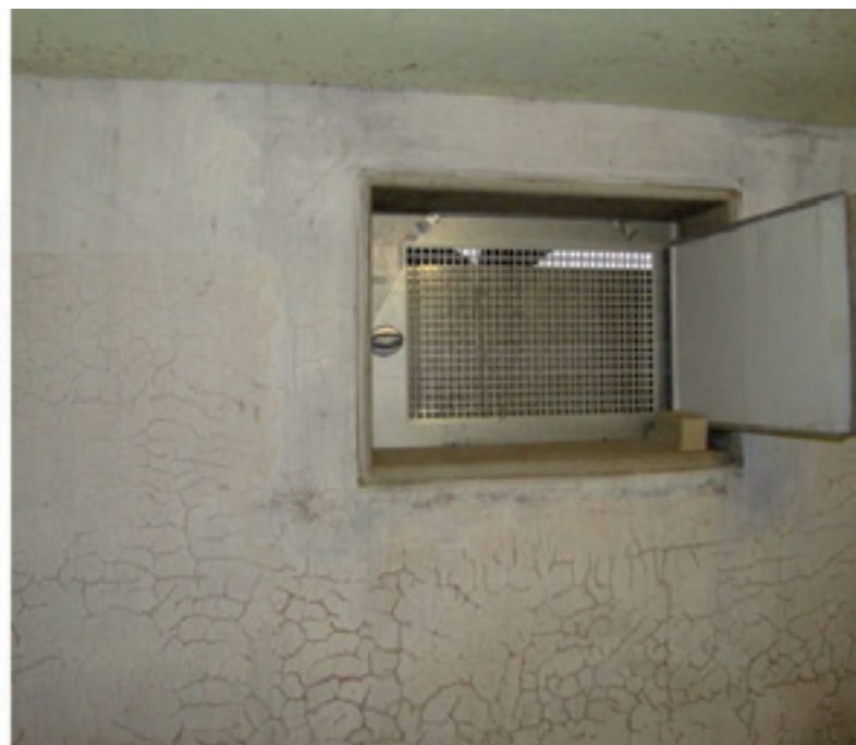
Abb. 37: Nachträgliche Einbauten an Tür und Kellerfenster zum Schutz gegen eindringendes Wasser
