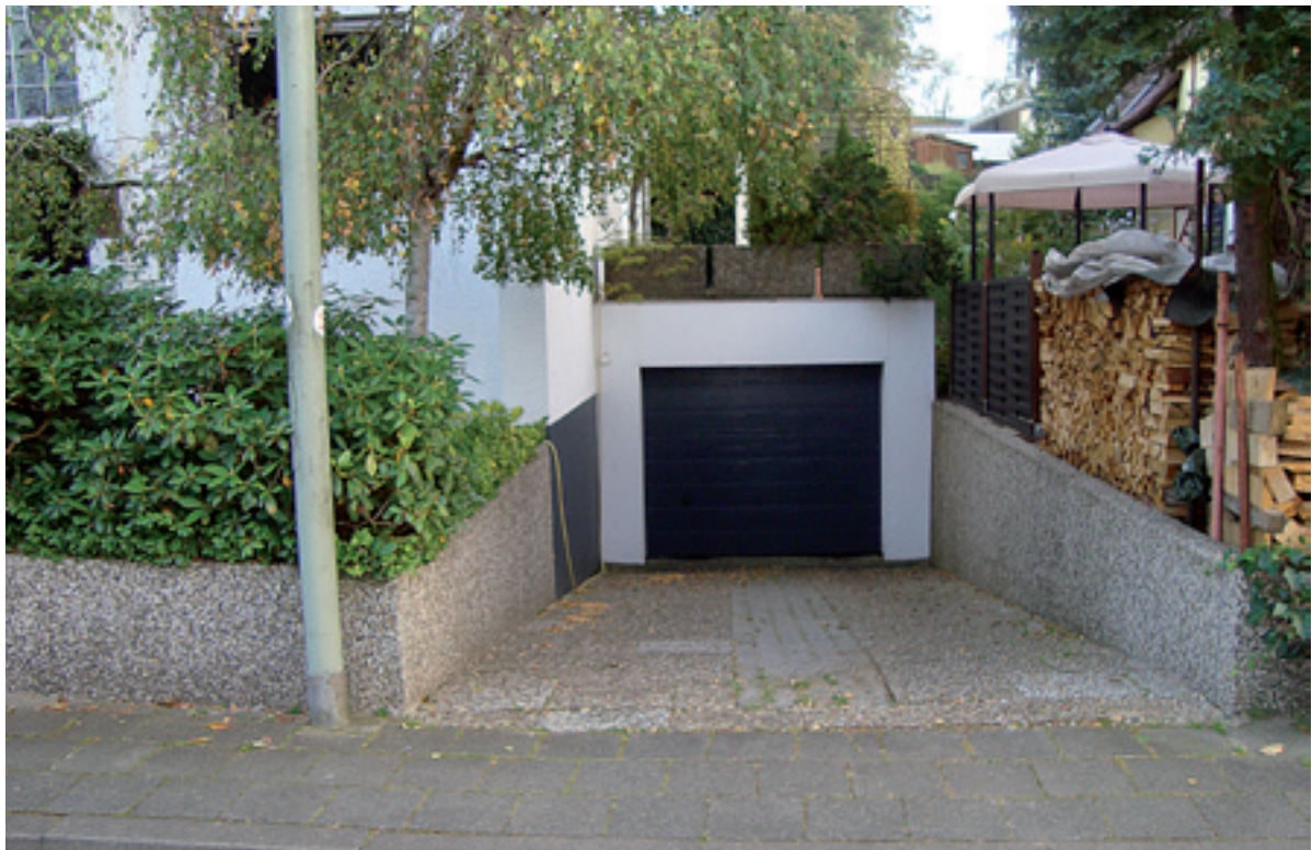
Abb. 17: Abschüssige Garageneinfahrt, an der das Wasser ungebremst in die Garage fließen kann
